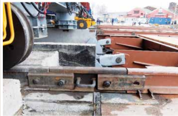
Рис. 8. Переходные рельсы и задержники
