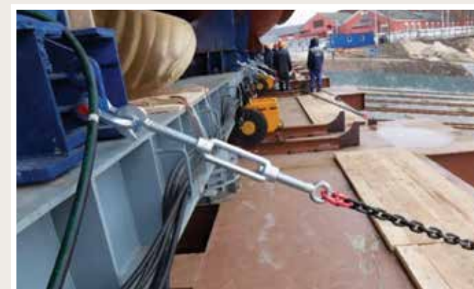
Рис. 17. Раскрепление ступельного поезда на платформе
