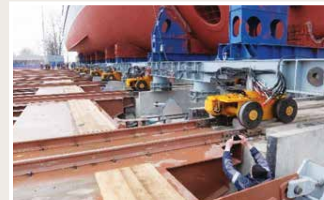
Рис. 14. Ступельный поезд перед переездом на платформу
